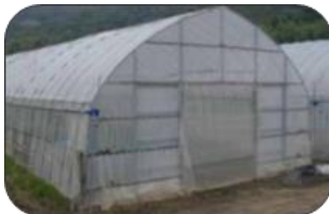
パイプハウス（塩化ビニルファルム・ポリオレフィン系フィルム）
